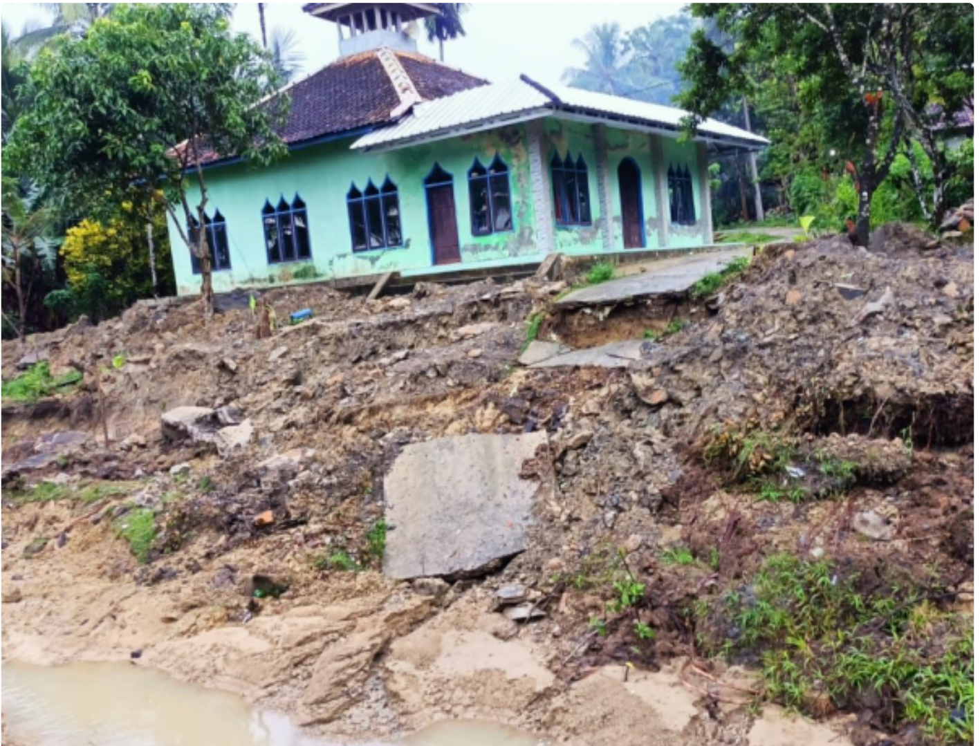
Longsor sekitaran pengerjaan proyek DI Cikoncang ke Musala
